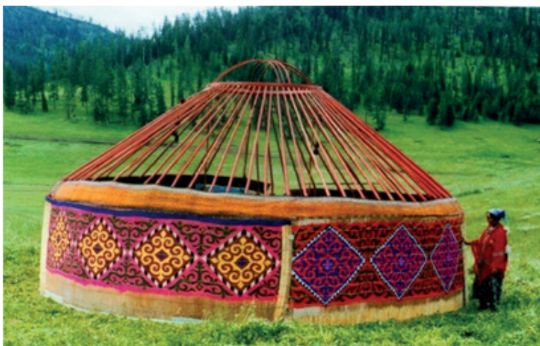
Сурет 13 - Киіз үй қаңқасына шымшидың ұсталған сәті
